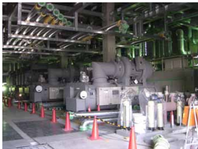
冷凍機 (熱源機械棟)
